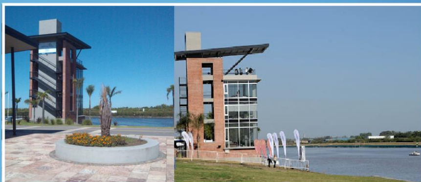
Torre de Llegada
